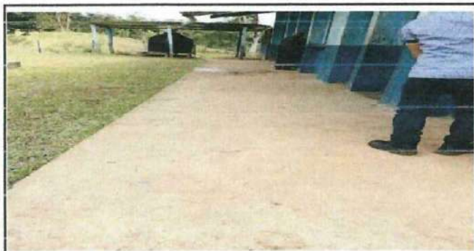
Foto 3: Remozamiento de piso exterior
