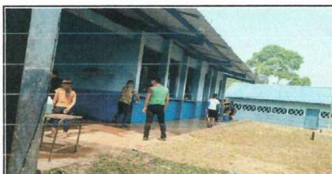
Foto 5: Puertas y ventanas
