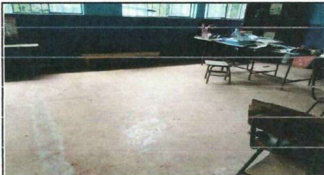
Foto 2: Remozamiento de piso interior
