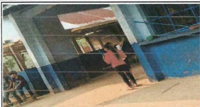
Foto1: Rehabilitación de paredes
